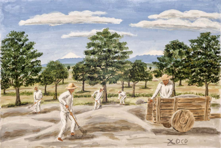
© Raúl Chiquito. Elevando suelo . Subiendo el nivel del terreno para la construcción del templo.
