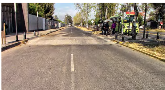
Figura 3. Ejemplos de topes en el mundo real. Obsérvese que las distintas condiciones del tope, señalización y pavimentación dificultan su detección tanto por humanos como por computadoras.
