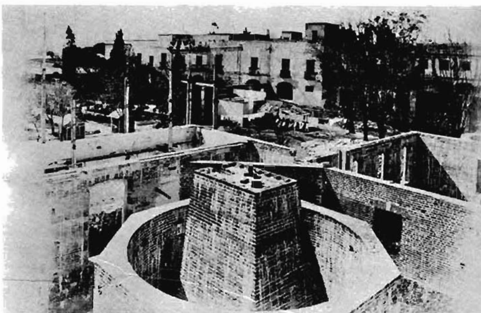
Vista de la construcción del Observatorio Astronómico Nacional de Tambora. En primer plano, base para el Gran Ecuatorial.
