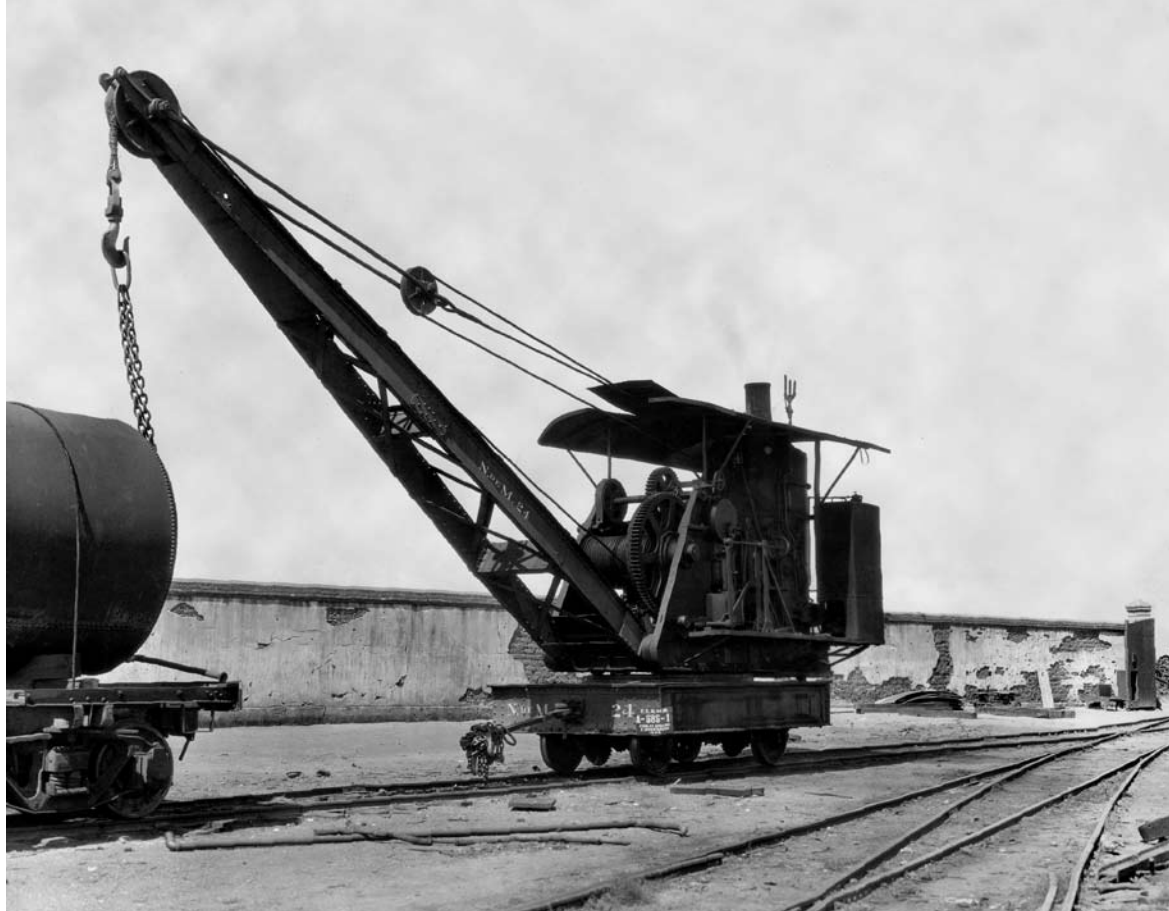
© Grúa de vapor para el servicio en el patio de los talleres de Aguascalientes, 1926. Fondo Comisión de Avalúo e Inventarios. CONACULTA/CNPPCF/MNFM.
