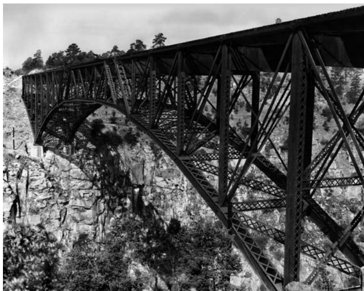
© Puente de armadura tipo Cantelever en el río Chico, 1929. Fondo Comisión de Avaluó e Inventarios. CONACULTA/CNPPCF/MNFM.
